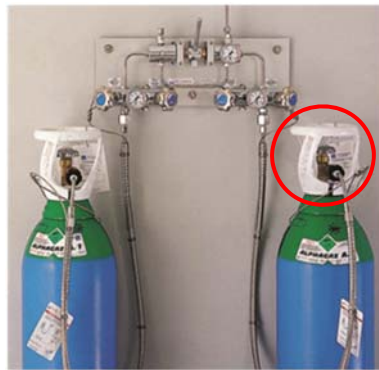
รูปที่ 2.3 ตัวอย่างถังแก๊สที่มี guard ป้องกันหัวถัง ขณะใช้งาน
